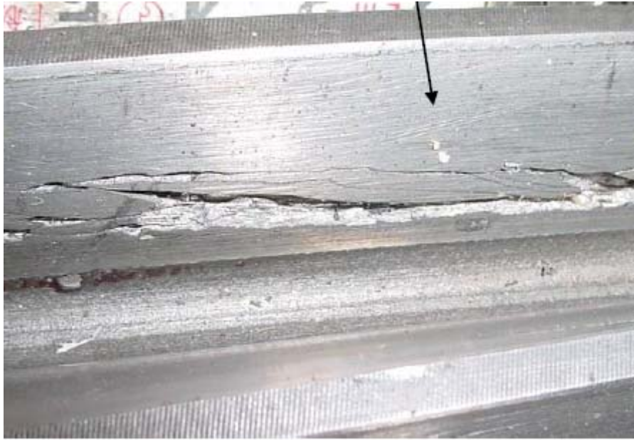
Figur 8: Eksempel på case crushing i et lidt mere fremskreden stadie med udfald af lange splinter af overfladen.
